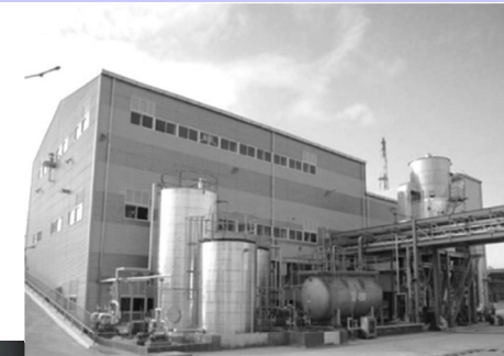
超臨界水熱合成法によるナノ粒子合成装置 (Hanwha Co.製, T. Adschiri et al., Green Chem., 13, 1380–1390 (2011)より引用)
